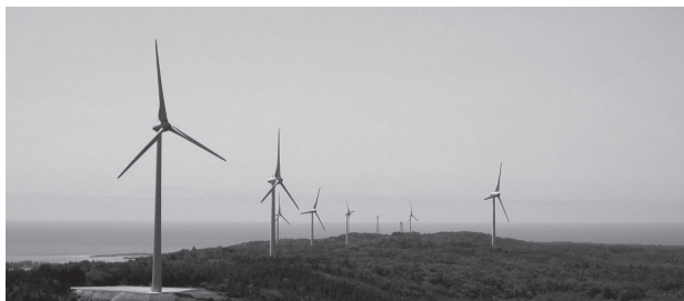
【風力発電建設工事】
