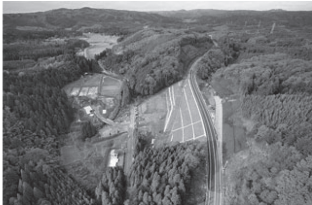
【災害復旧工事】
