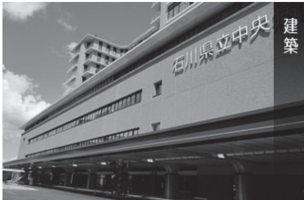
【病院建設工事】
