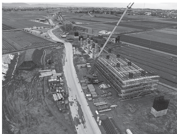
【新幹線建設工事】
