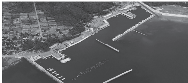
【漁港・港湾工事】
