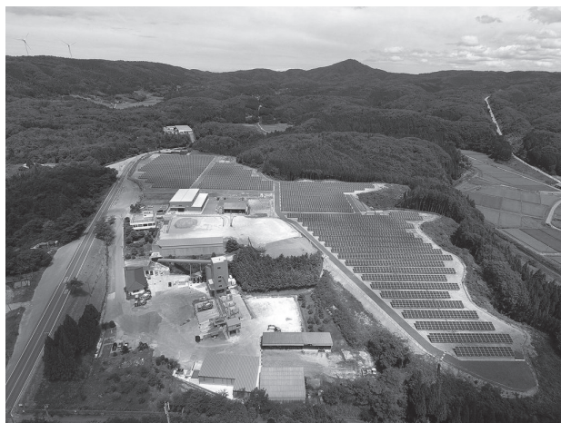
【本社、生コンプラント、太陽光発電施設】
