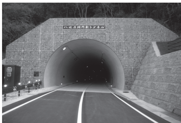
【トンネル工事】
